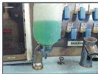
よく見る手洗いの液体石鹸ですが、石鹸が出るところに細菌がつくおそれがあるのでダメ。自動式に変更予定です。
