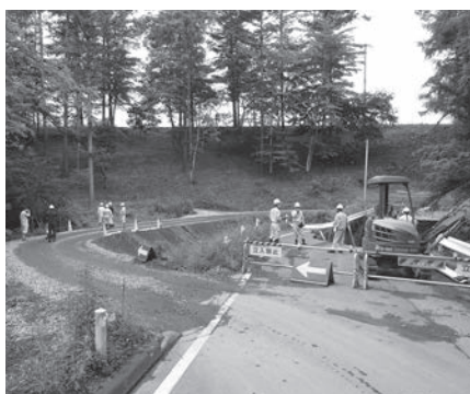
町道9-9号線アテロ地内（小菅側）
