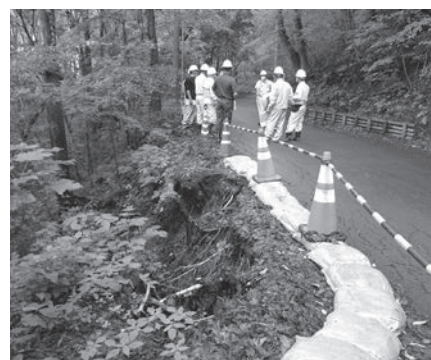
町道北軽湯沢線（大学村地内）
