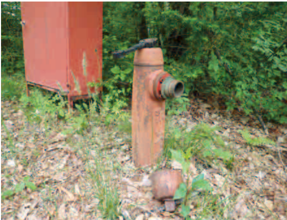
▲受理番号9号 消火栓の新設や修繕について (写真：老朽化のため開閉弁操作不可)
