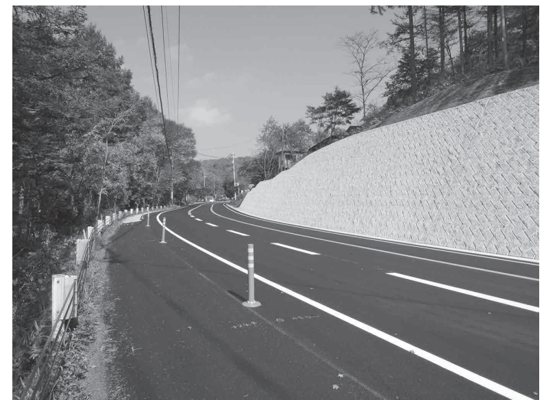
2車線になった国道292号
