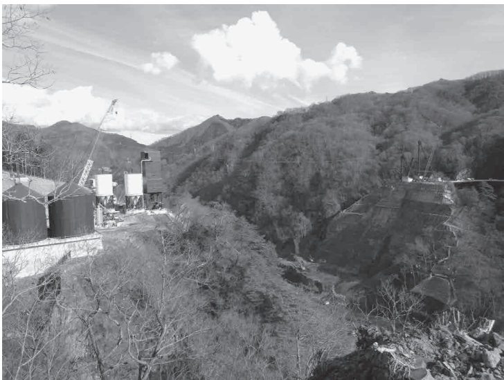
やんば見放台から望むダム本体建設現場
