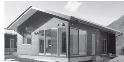
▲町営上湯原住宅（平成28年2月撮影時）
