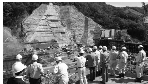
▲ 本体工事現場の現地視察
