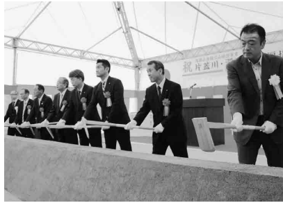
▲ 着工式（鉄入れ）の様子
