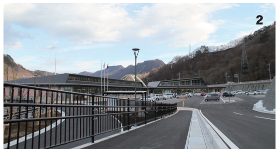
1. 長野原草津口駅自由通路へエレベータを設置します 2. 12月25日に開庁となった新庁舎
