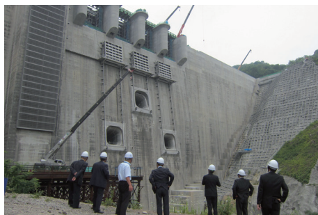
試験湛水を開始したハツ場ダム
