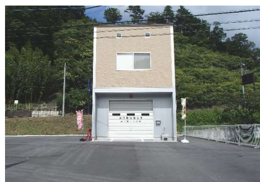
□■長野原消防団詰所■□
